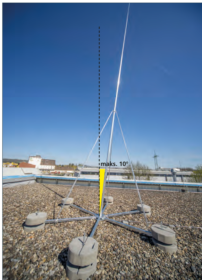
Przegub kulisty umożliwia dopasowanie masztu do nachylenia dachu lub budynku o maksymalnie 10°.
