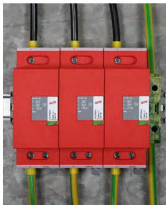
Montaż ogranicznika – zatrzaśnięcie na szynie TH35
