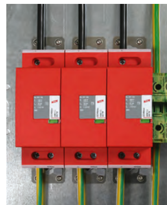
Montaż na płycie z wykorzystaniem dwóch zaczeów (dostarczane w komplecie)
