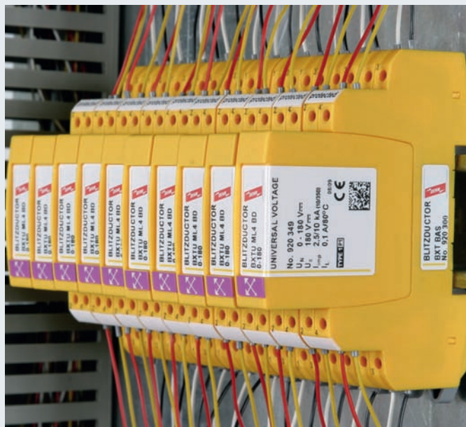
Grupa BLITZDUCTOR XTU zastosowana w instalacji.
